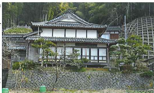
写真1 玄武岩の石垣 *研究室の協力のもと撮影
